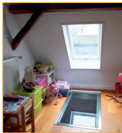
Puits de lumière aménagé dans le plancher pour éclairer le rez-de-chaussée.
