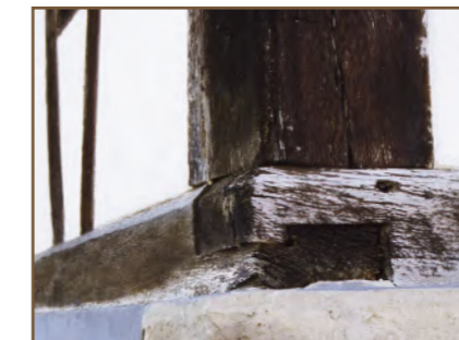
Assemblage au niveau du poteau cornier
