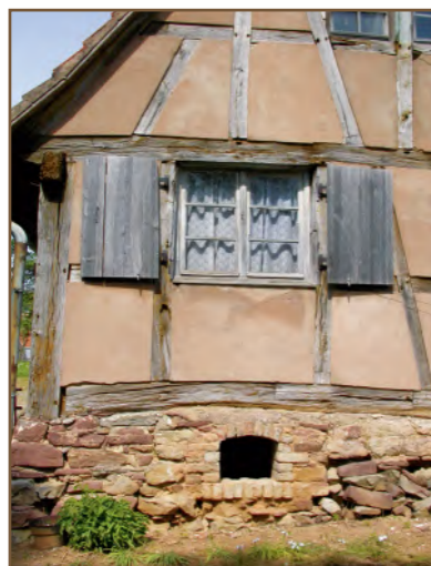
Mixité des matériaux : grès, brique, bois, torchis...
