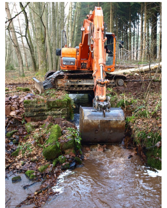
Elimination d'un seuil de fond
