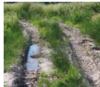
Tassement du sol lié aux passages d'engins Photo : SYCOPARC
