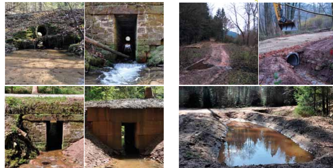
Contrat N2000 et financement Fondation Electricité de Strasbourg, projet de restauration du Fischbaechel, porté par l'ONF : suppression d'une digue d'étang, reprofilage du lit mineur sur 30m, remplacement de buses sous-dimensionnées par un pont cadre en grès Photos : SYCOPARC
