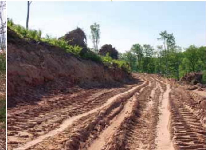
Elargissement d'une piste forestière Photo : SYCOPARC
