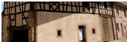
Enduit traditionnel à la chaux naturelle
