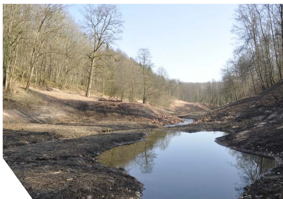
2022 - La même vue après la suppression de l'étang de barrage. Le ruisseau a ainsi repris son cours normal et progressivement, la végétation va recoloniser le milieu.
