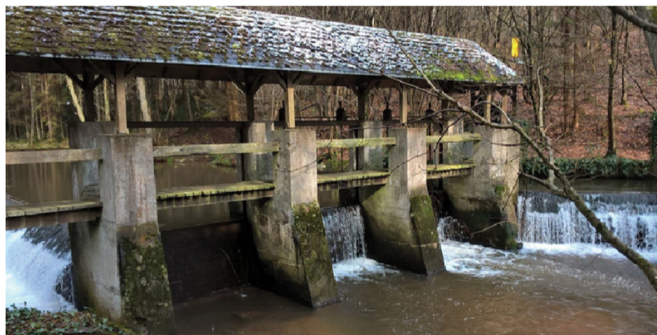
Le barrage est essentiel pour l'exploitation hydroélectrique de Weiler. Il permet de maintenir le niveau d'eau en amont de l'ouvrage de manière à alimenter le canal d'amenée à la turbine.
