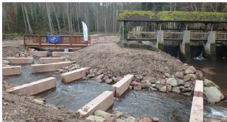
Avec ses 18 cloisons successives, la rivière de contournement a permis de rétablir une hauteur de chute maximale de 1,6 m. Entre chaque cloison, un pseudo-bassin d'une longueur de 3 m et d'une largeur de base de 1,4 m a été aménagé.
