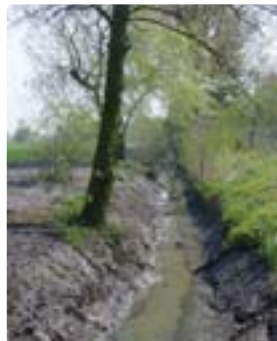
Destruction d'un ruisseau suite à un curage mécanisé
