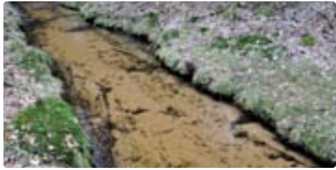
Ralentissement des écoulements et ensablement du lit sont les premiers symptômes perceptibles du déséquilibre du milieu suite aux travaux de recalibrage
