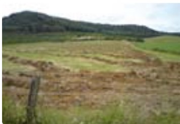
Pose de drains agricoles en zone humide*
