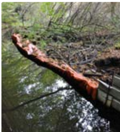
Berge bricolée par des riverains. En plus d'être totalement inefficace à moyen terme, ce type d'aménagement est une calamité paysagère.
