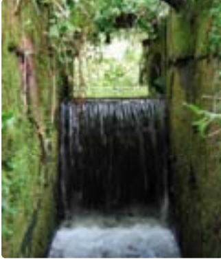
Ouvrage hydraulique en barrage créant une déconnexion amont-aval
