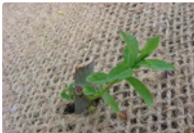
Bouturage de saule pour fixer rapidement le talus des berges - Service rivière - CG67
