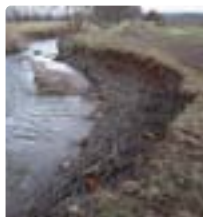
Stabilisation par un « peigne » d'une berge subissant une forte érosion.
