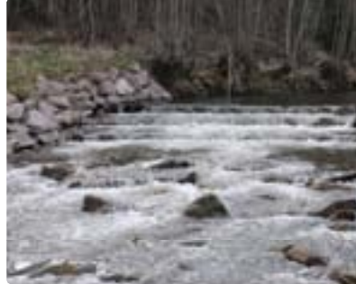
Exemple de passe à poissons constituée de bassins successifs en enrochements
