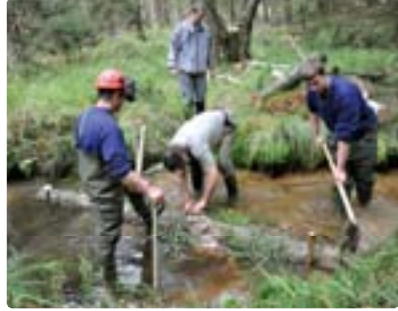
Mise en place d'un déflecteur rustique en rondin de bois dans un ruisseau ensablé
