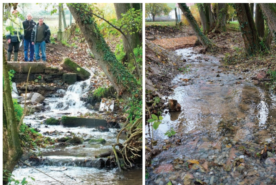
Avant/après des travaux de suppression d'obstacles sur la rivière du Soultzbach , 2015
