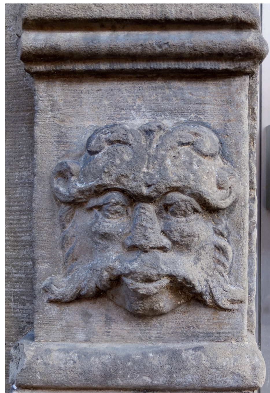
Détails d'une façade avec des encadrements de porte en grès sculptés
