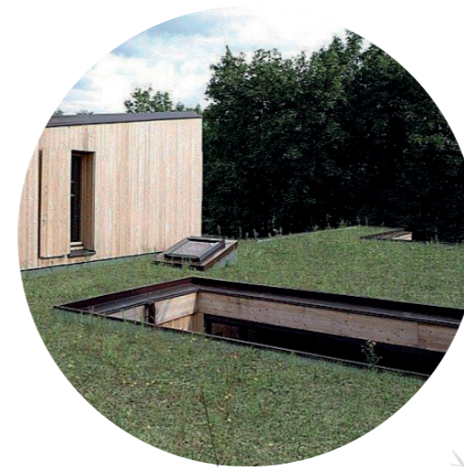
Toit terrasse (toit plat)
