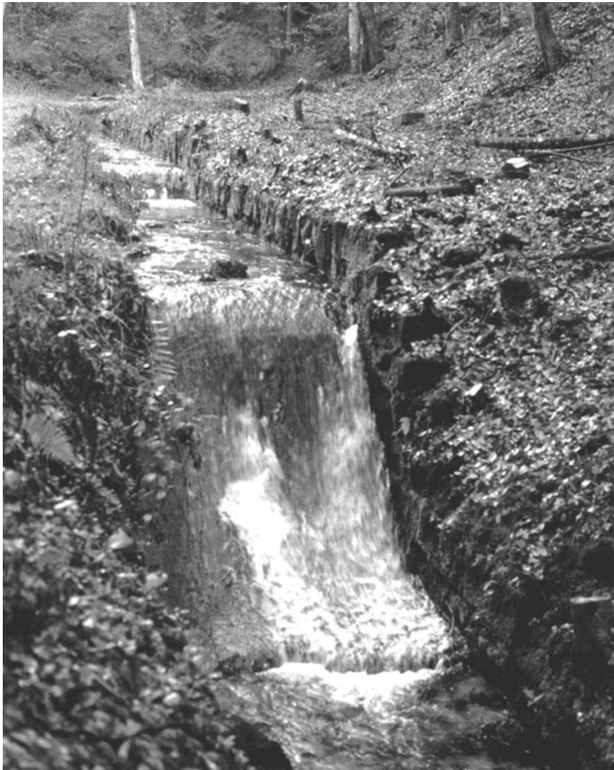
Abb. 8 : Die meisten größeren Bäche des Pfälzerwaldes sind bis in den Quellbereich hinein für die Holztrift kanalisiert und ausgebaut.
