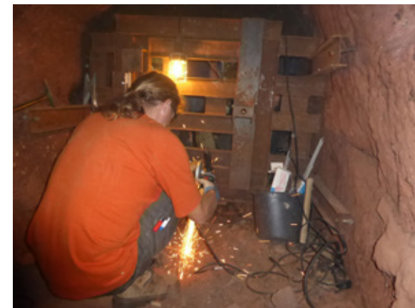
Abb. 7 : Die Vergitterung von Stollen und Bunkern aus Gründen des Fledermausschutzes muss auch den Unterhaltungsaufwand in Form regelmäßiger Kontrollen und im Bedarfsfall die Reparatur beschädigter Gittertore berücksichtigen (Foto: G. Pfalzer).
