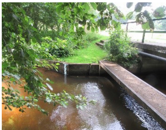
Photo 4 : Une échelle limnimétrique. Ici pour la station de la Zinsel du Nord à Baerenthal. Photo Sycoparc.
