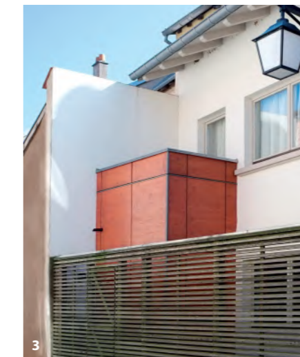
Aménagement d'un logement et travail sur l'intimité par rapport à la rue
